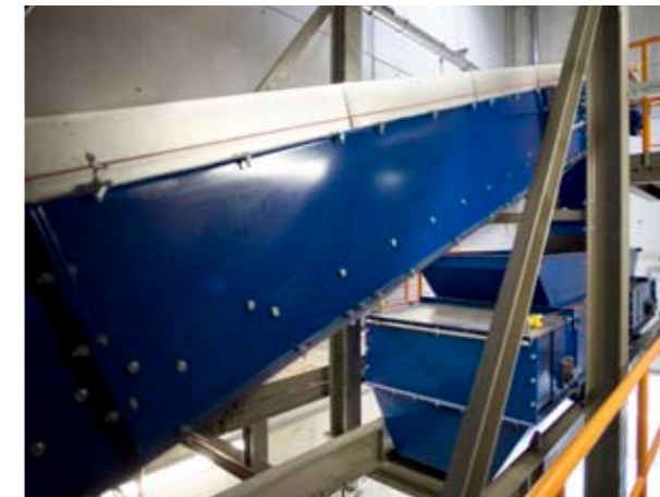
Der SIEBÜBERLAUF wird in Container gefördert The SCREENING OVERFLOW is transported into a container
