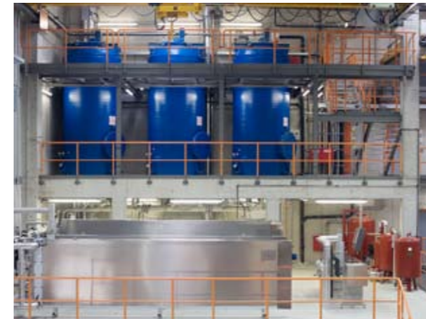
Für den kontinuierlichen Betrieb sorgen drei HYGIENISIERUNGSBEHÄLTER Three HYGIENISATION CONTAINERS are used for the continuous operation
