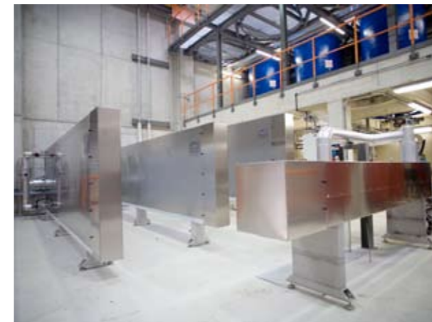
Die WÄRMETAUSCHER sorgen für die richtige Temperatur der Suspension The HEAT EXCHANGERS provide the right temperature for the suspension
